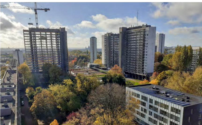
> Modelwijk: renovatie, bouwheer - De Lakense Haard
