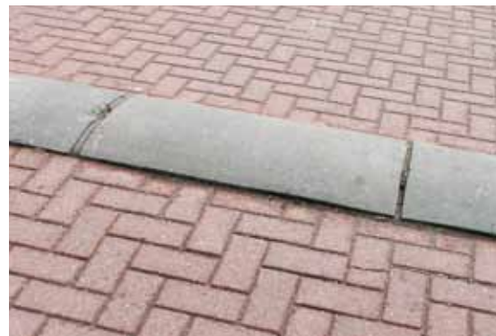
Louvain-la-Neuve, rue A. Chavée. Eveneens een eenvoudig niveauverschil: een op het wegdek gekleefde ribbelstrook. Een groot niveauverschil is immers niet altijd mogelijk door de configuratie van de locatie.
