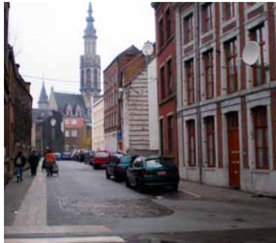
Verviers. De wegbeheerder voorzag een gidslijn langs heel de weg. Deze inrichting is ietwat overdreven. Aan de kant waar de gidslijn aangebracht werd, is er immers geen enkele ingang of activiteit voorzien.
