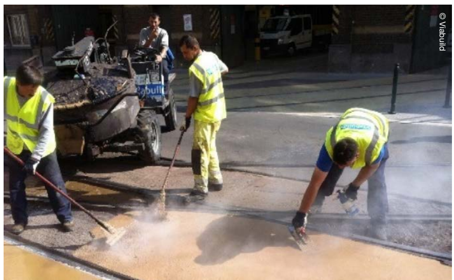
> Aanleg van okerkleurig gietasfalt
