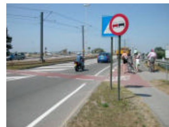
Deux bandes de circulation ont été réduites à une seule grâce à une zone d'évitement, le panneau C35 n'est plus nécessaire.
